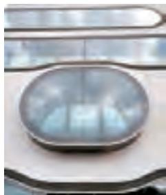
Edificio per uffici ad Amburgo, ancora un progetto di Jürgen Mayer H.: in alto il prospetto principale e sotto alcuni dettagli degli inserti trasparenti della facciata ventilata
