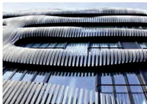
Semplici profili tubolari in alluminio "mettono le ali", ovvero vengono modellati in una sezione composta che sostanzialmente presenta due piatti affacciati longitudinali sagomati nel loro sviluppo in altezza secondo linee curve, con macchine a controllo numerico.
